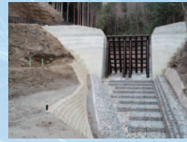
芦沢砂防堰堤
